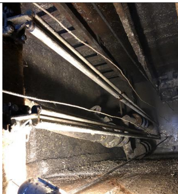
Трубы в КНС №1 после ремонта
